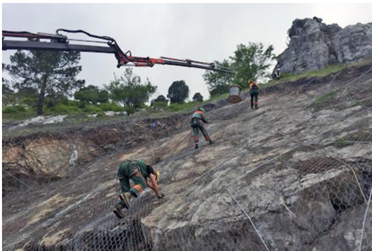
fig 03 – L'addetto all'uso di braccio gru deve mantenere la piena e costante visibilità degli elementi sollevati e in spostamento
