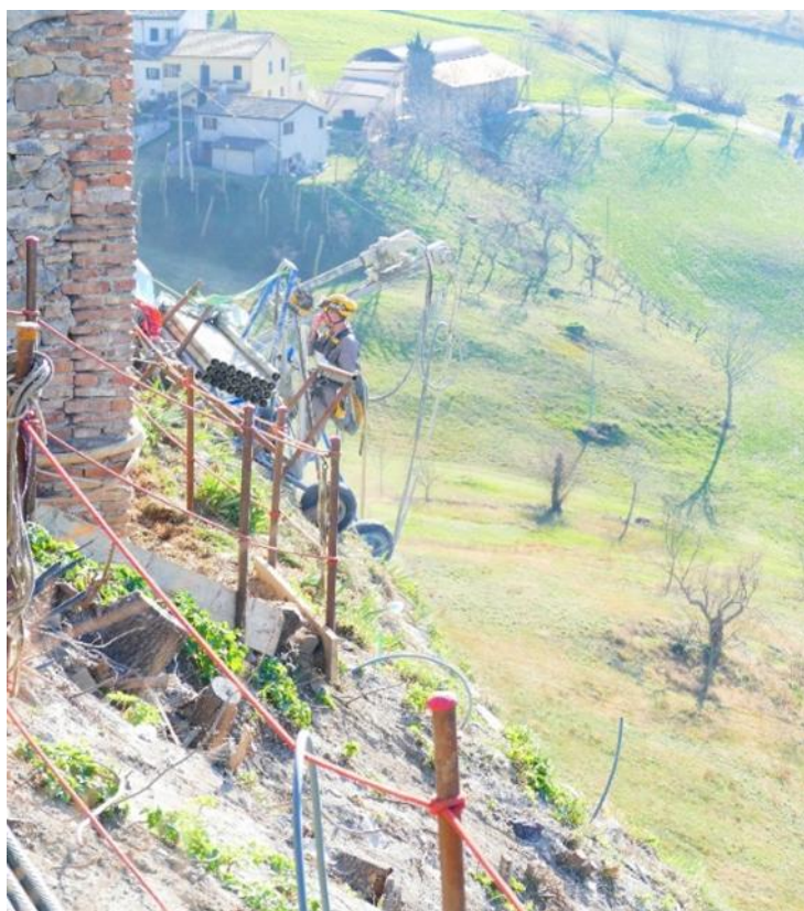
Fig. 9 Accantieramento e camminamenti in sicurezza alla sommità parete da chiodare
