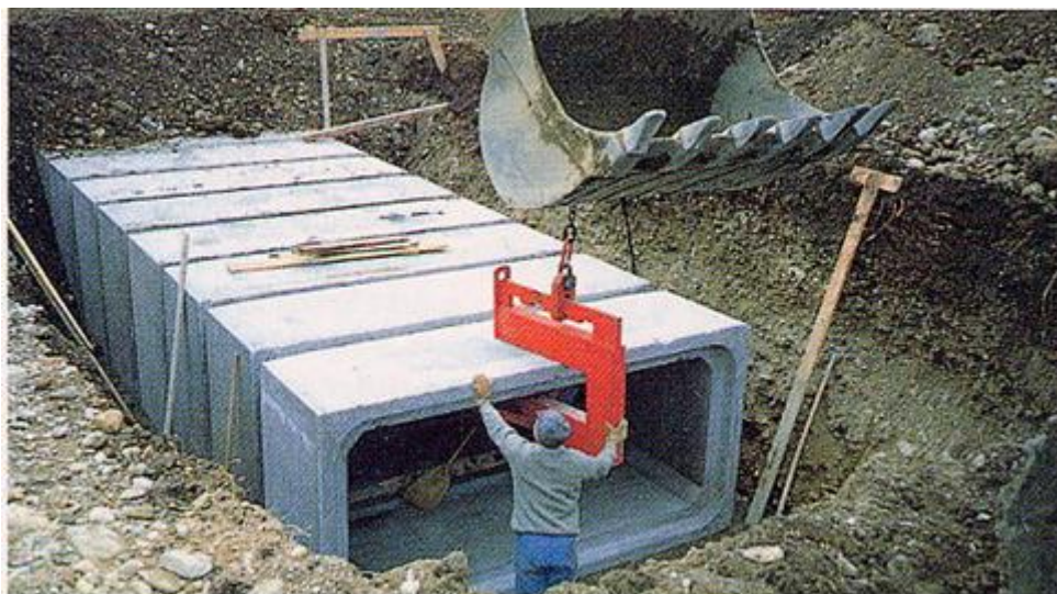
fig. 3 – posa di elementi scatolari con idoneo gancio a “C” per il sollevamento e MMT omologata ISPESL come mezzo di sollevamento
