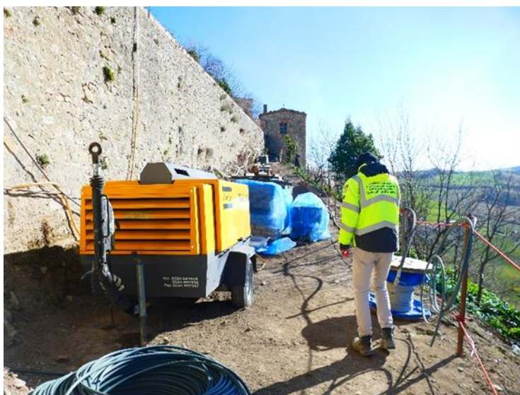
Fig.8 – Accantieramento e camminamenti in sicurezza alla sommità parete da chiodare
