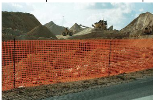
Fig. 05 – delimitazione area di cantiere con montanti da controventare, ad interasse consigliato di 2 m.
