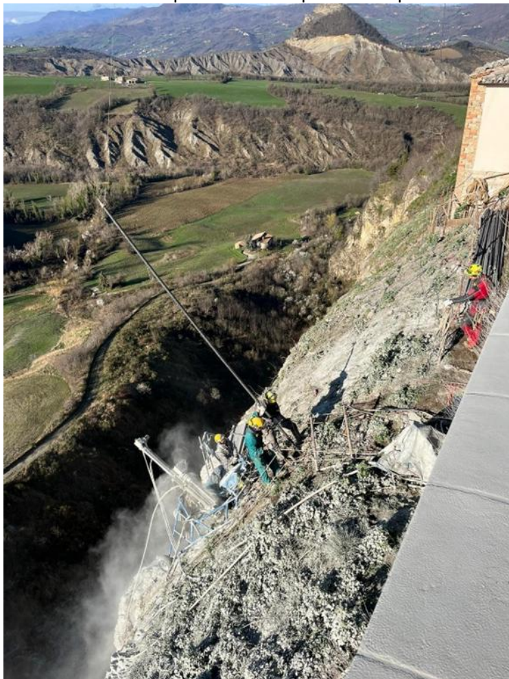
Fig. 11 - Infilaggio barre tipo Gewi - L'addetto al sollevamento meccanico della barra di ancoraggio deve avere costantemente la piena visibilità dell'elemento sollevato e dell'addetto all'infilaggio
