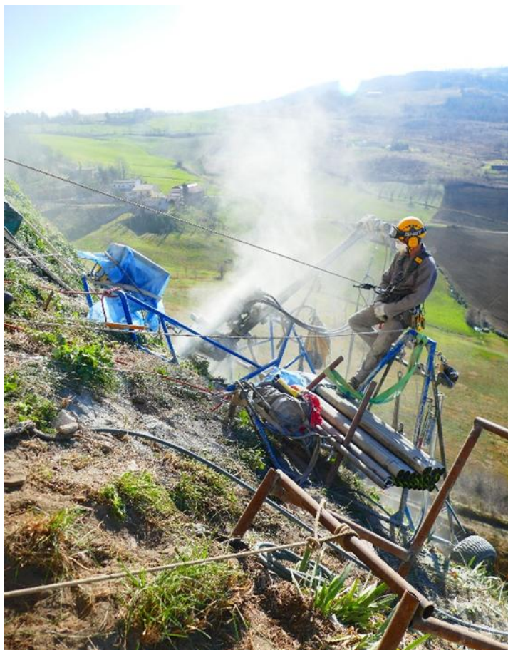
Fig 7 – L'addetto alla perforatrice deve mantenere la piena e costante visibilità del rotopercussore
