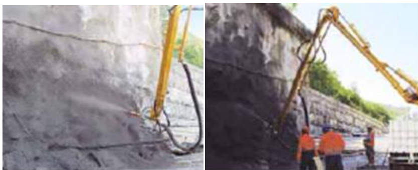
fig. 2 e 3 – spritz beton con braccio idraulico a distanza
