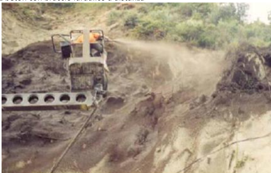
fig. 4 – spritz beton con uso piattaforma aerea
